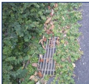
また排水溝の蓋(グレーチング)に雑草等が覆いかぶさっているケースも見受けられます。このような状況だと、大雨が降った時に排水溝へ水が流れず周辺道路に溢れてしまいます。
